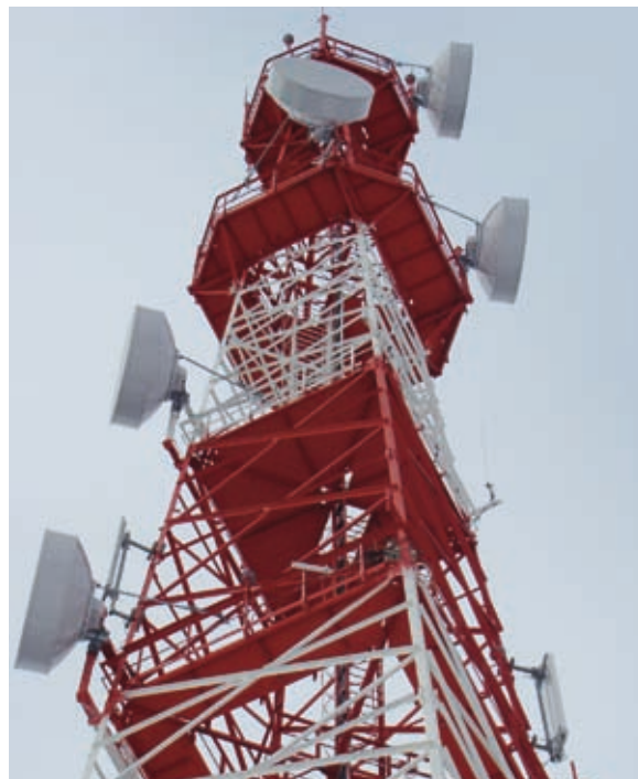
Антенно-мачтовое сооружение в г. Урай (ХМАО-Югра)
