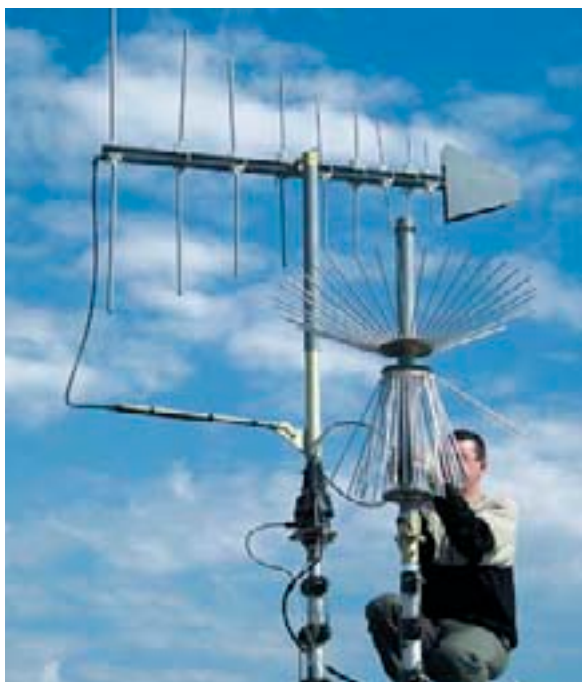
Монтаж антенны мобильного радиоконтрольного комплекса
