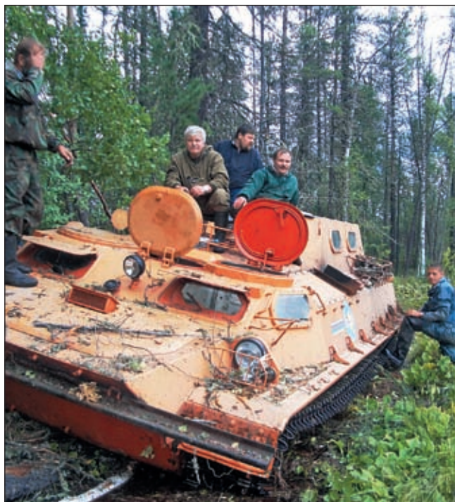
Прием в эксплуатацию ВОЛС Томского филиала ОАО «Сибирьтелеком»
